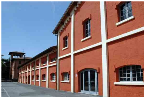
La Biblioteca di Castelfranco
